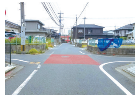
注意喚起カラー舗装 (浅生1丁目2.3.5.6交差点)
